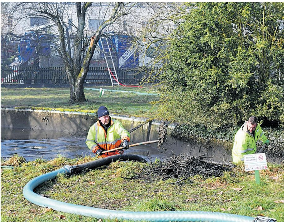
Sämi Stutz von der Kanalreinigungsfirma und Silvan Schenk, Mitarbeiter der Werkbetriebe, entfernen Gehölz aus dem Teich, während der Schlamm per Schlauch vom Saugfahrzeug aus dem Teich gesaugt wird.
